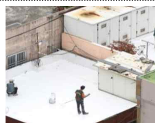
건물 옥상면 시공 전경
