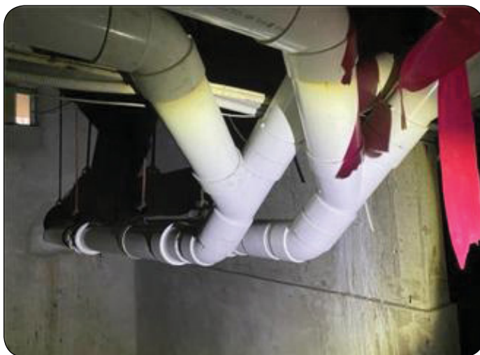
공동주택 오배수관 교체공사(후)
