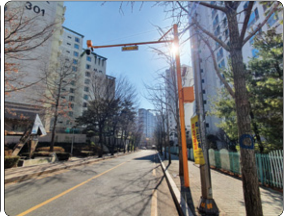
CCTV 설치 현장
