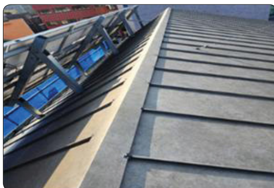
방학동도깨비시장 고객지원센터 지붕 개보수
