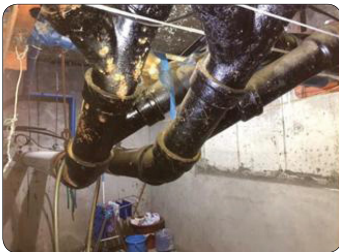
공동주택 오배수관 교체공사(전)
