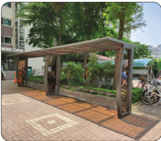
공동주택 자전거보관대 설치 지원
